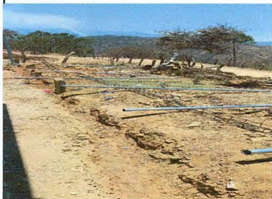
Foto 1: MEJORAMIENTO DE CERRAMIENTO PERIMETRAL
