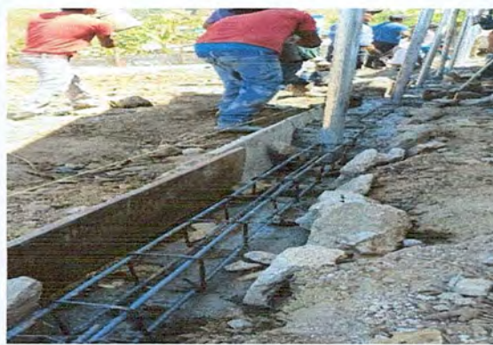
Foto 2: Instalación de hierro para cerramiento perimetral
